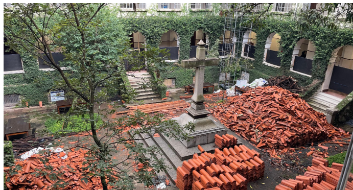
O Pátio da Cruz interditado e sendo utilizado como depósito da reforma
