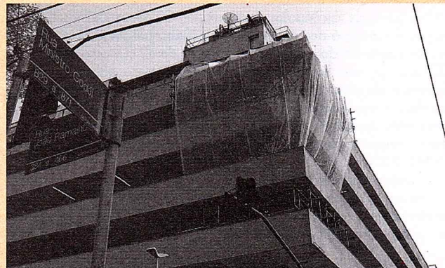
Nas laterais do Prédio Novo as obras já começaram
